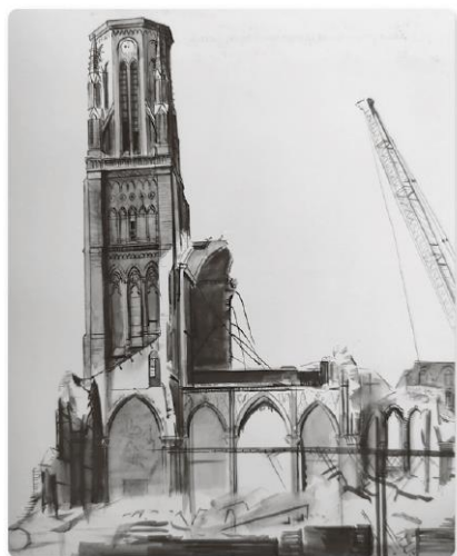
De sloop van de St. Vincentiuskerk te Amsterdam, gezien vanaf de Kanaalstraat; 1989
